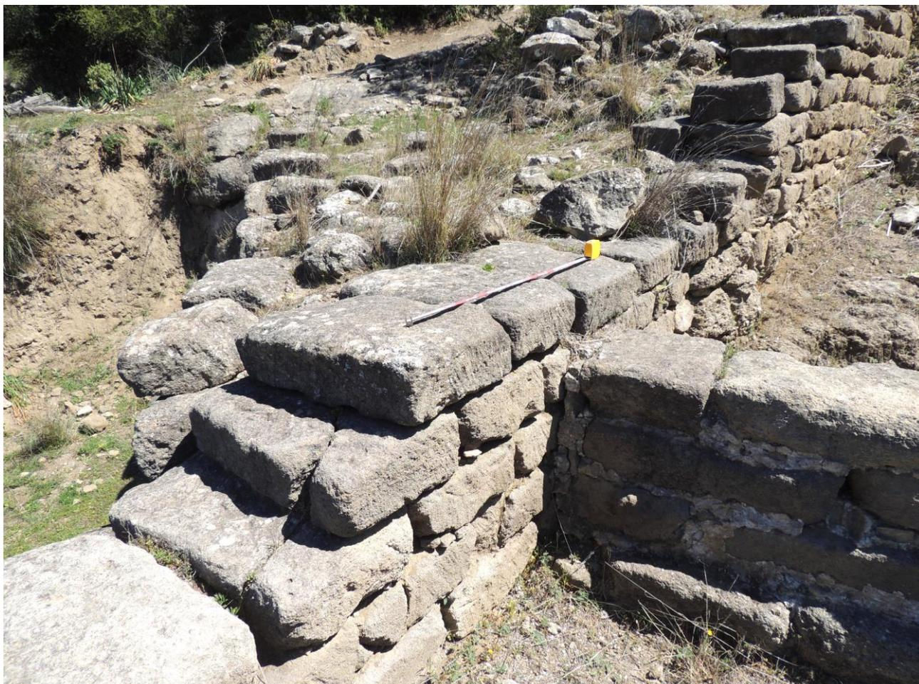
**Figura 8.** Hoja exterior del muro de doble paramento con sillares a tizón colocados en posición horizontal, y adosamiento de la estructura de torre (sin encastré). Autoría propia
