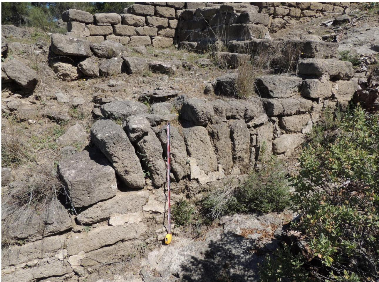
**Figura 6.** Detalle constructivo en el frente sur de la torre: hilada de tizones descansando sobre sogas.
