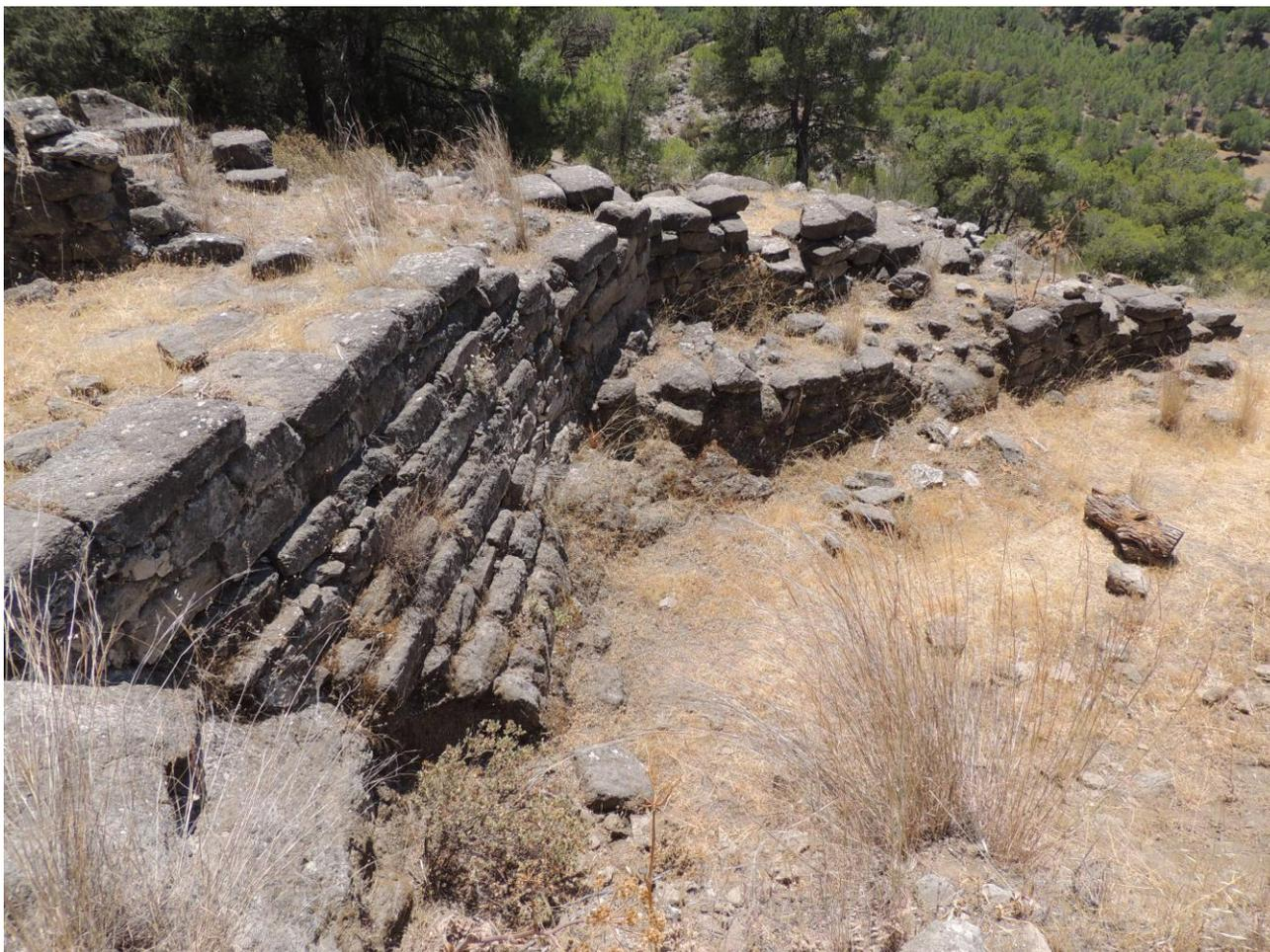
**Figura 5.** Hiladas inferiores escalonadas a modo de zarpa y cimentación con piezas a tizón. Autoría propia
