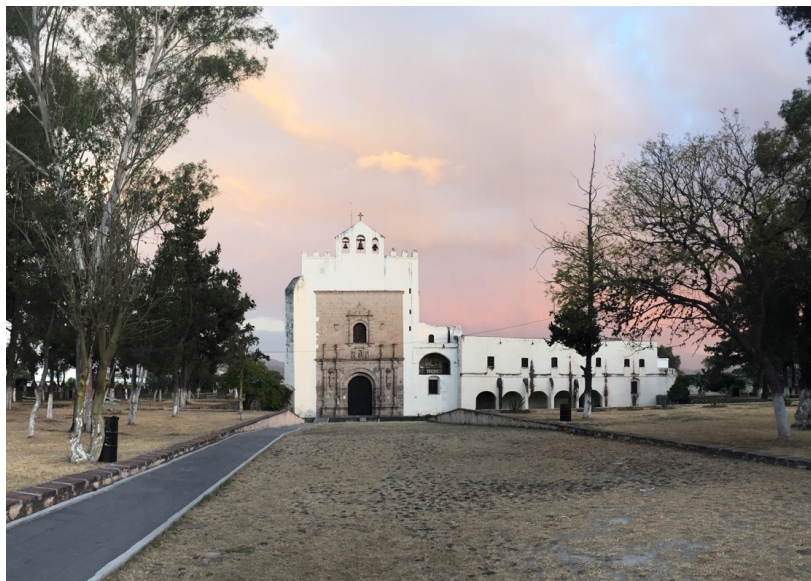
Fig. 16: Convento de Acolman, vista general de la fachada delante del atrio.
